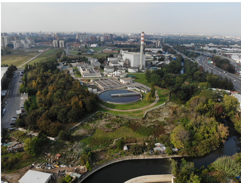
Veduta generale degli impianti e dell'intorno
